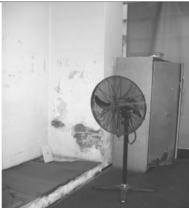
Foto N° 11 – En la presente vista podemos observar en el interior de la oficina de este Organismo, a la derecha un armario metálico que sirve de cierre-tapón al pasillo que corre paralelo al frente vidriado que da a la calle Carabelas, a la izquierda un boquete realizado por operarios que buscaban el origen de la humedad que presenta esta pared y que si bien no encontraron el origen de la misma tampoco arreglaron lo destruido y en el piso un escalón sin revestimiento en el frente y donde se observamos manchas de humedad en el material a la vista y también podemos ver el piso de madera flotante roto en la esquina y con la alfombra que lo recubre también deteriorada.
