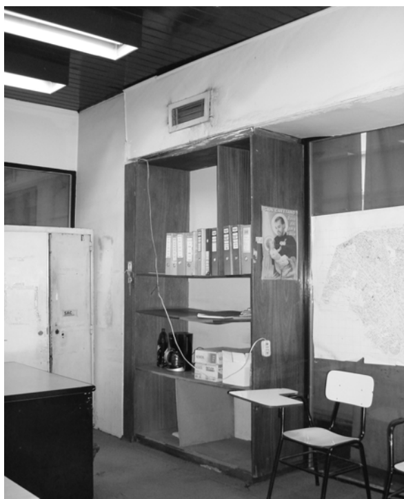
Foto N° 9 – Vista del interior de la oficina del personal de este Organismo donde podemos observar en el cielorraso junto a la pared que el recubrimiento del ducto del AA presenta huellas de humedad de una filtración de agua y más abajo un cable de electricidad expuesto y encintado que alimenta un tomacorriente exterior colocado sobre el lateral de un mueble de madera.
