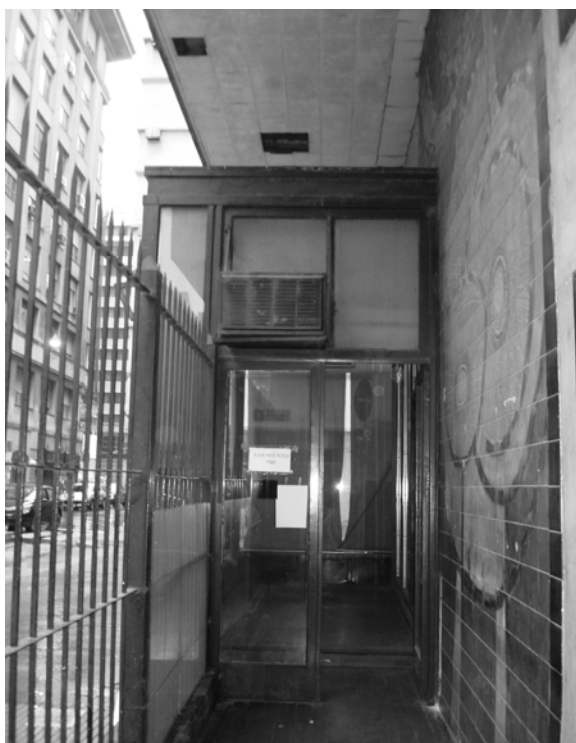
Foto N° 4 – Frente de las puertas del acceso al Organismo de Seguridad Vial por la calle Sarmiento, en la presente vista se puede observar la reja que da a la calle por la que han accedido delincuentes a la parte superior de esta entrada y desde allí a las oficinas del Director.
