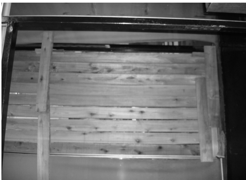
Foto N° 5 – Paño del frente de este Organismo que da a la calle Sarmiento donde podemos observar que el mismo tiene un cerramiento “provisorio” de madera colocado por la Guardia de Auxilio en reemplazo de un vidrio que fue roto desde la calle por desconocidos.
