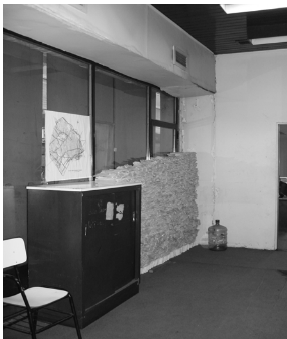
Foto N° 7 – Vista del tabique vidriado que da al pasillo de la foto N° 6, desde el interior del Organismo se puede observar que para disimular la vista que ofrece el citado corredor colocaron un mueble, un cuadro y pilas de talonarios de infracciones usados tapándolo. Asimismo la pared de fondo presenta una grieta y manchas de humedad que continúan en el cielorraso el que sirve de tapa al ducto de AA el mismo tiene la parte inferior desprendida por efectos de la humedad.
